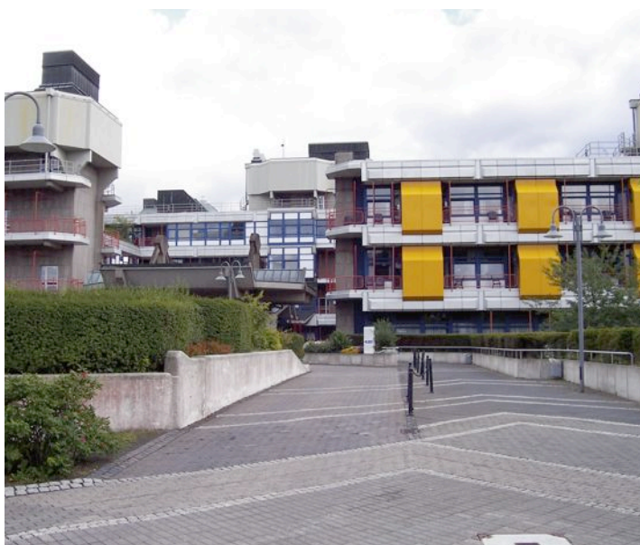
Teilsicht Marburg des Universitätsklinikums Gießen und Marburg.
