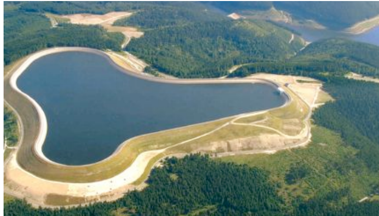
Das Pumpspeicherkraftwerk Goldisthal ist ein Referenz-Projekt der sauberen Stromerzeugung durch die Wasserkraft. Foto: Vattenfall
