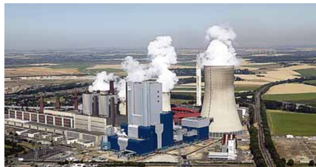
In Niederaußem befindet sich die erste BoA. Im Vordergrund (blau) der neue Block
