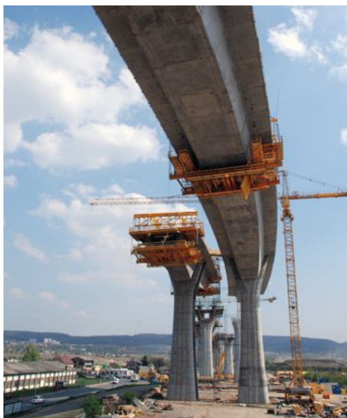
2.059 Meter lange Hochstraßenbrücke beim Prager Schnellstraßenring. © Bögl a Krysl
