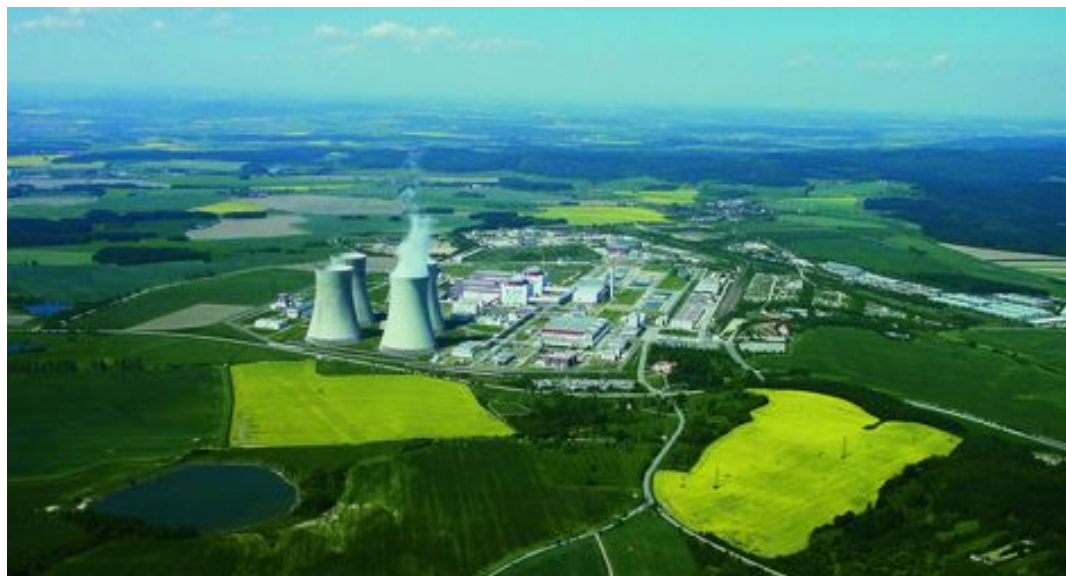
Das Kernkraftwerk Temelin (bei České Budejovice) gehört mit zwei 1.000 MW-Blöcken zu den modernsten Anlagen.
