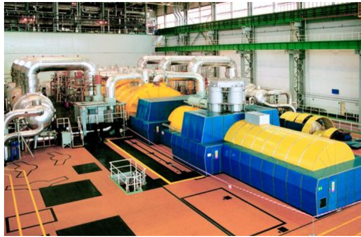
Einer der riesigen Turbo-Maschinensätze im KKW Temelin.
