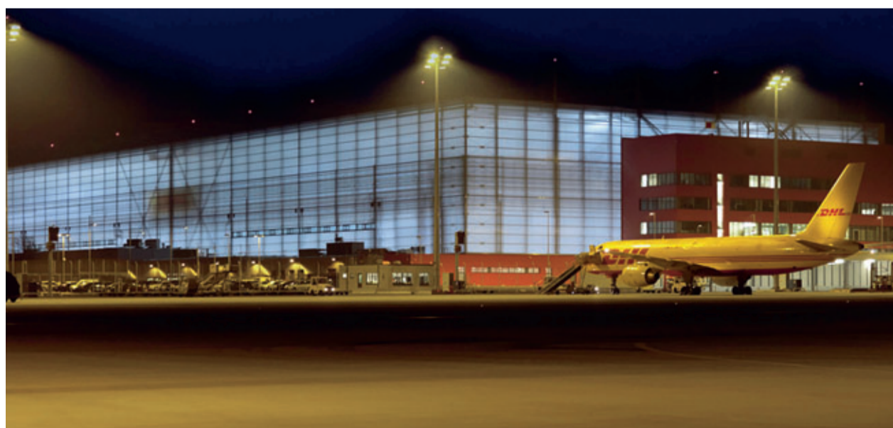
Ein Bauwerk der Superlative: Der Hangar des DHL-Hub in Leipzig ist das Wartungszentrum für die DHL-Maschinen.
