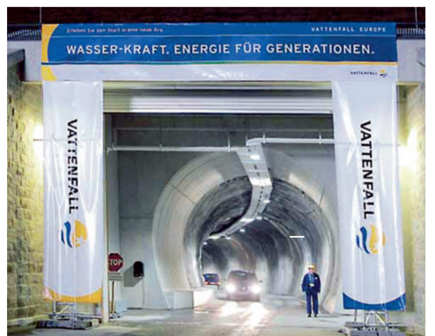
Die riesige Kaverne ist durch einen Zufahrtstollen erreichbar. 156.000 Kubikmeter Fels mussten für die vier Maschinensätze herausgebrochen werden.
