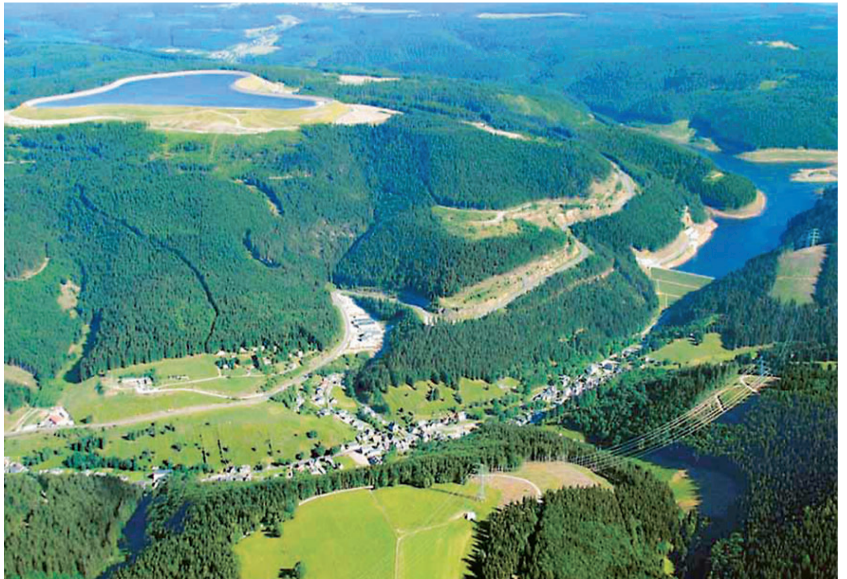
Technik und Natur im Einklang. Das Vattenfall-Pumpspeicherkraftwerk Goldisthal ist mit einer Leistung von 1.060 MW das leistungsstärkste Wasserkraftwerk Mitteleuropas.
