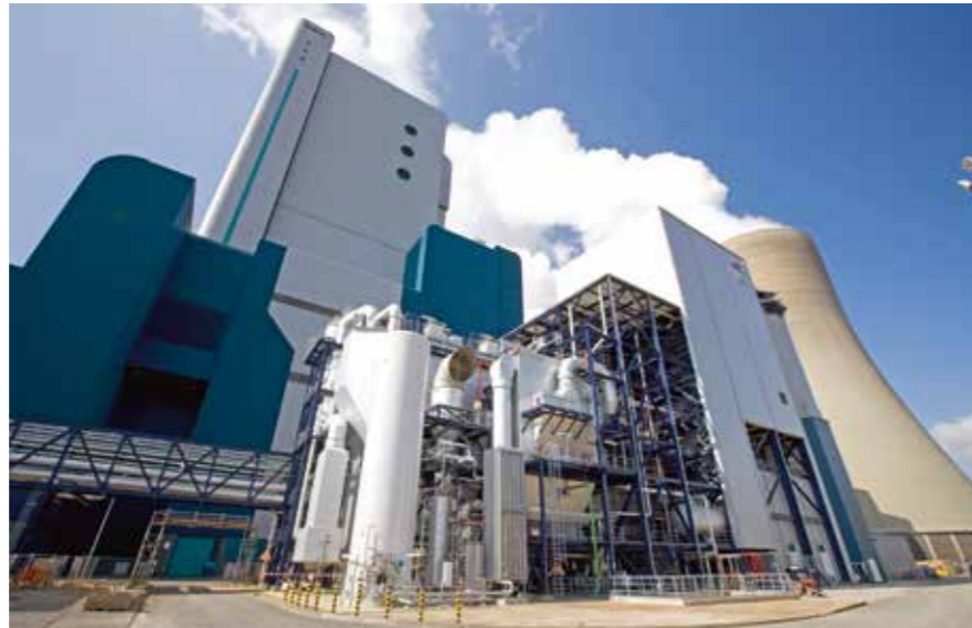
2002 war der westlich von Köln liegende RWE-Standort Niederaußem mit dem neuen Block BoA (Optimierte Anlagentechnik) das weltweit modernste Braunkohlekraftwerk der Welt. © RWE
