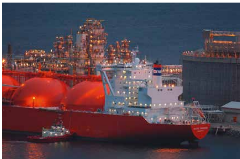
Spezialtanker – hier an der LNG-Anlage in Hammerfest – liefern das komprimierte Flüssiggas bis in die USA.
