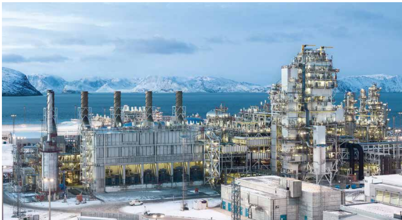
Hochkompliziertes Linde-Engineering beim Koloss von Hammerfest, einem „Leuchtturmprojekt“ der Gasverflüssigung (LNG).
