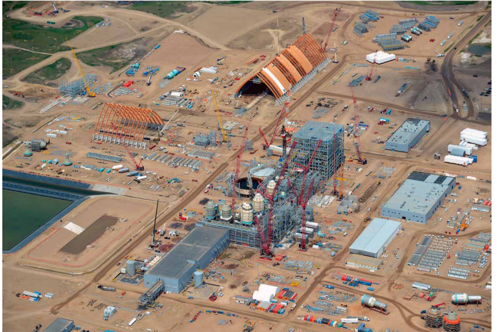
Das Mega-Projekt Legacy (Aufnahme der Baustelle vom Juni 2015) wächst seiner Vollendung entgegen und liegt im Finanz- und Zeitplan.
