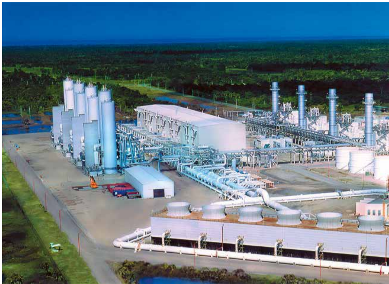
Riesiger Linde-Luftzerleger: Die Anlage liefert Stickstoff für die Öl-Produktion.
