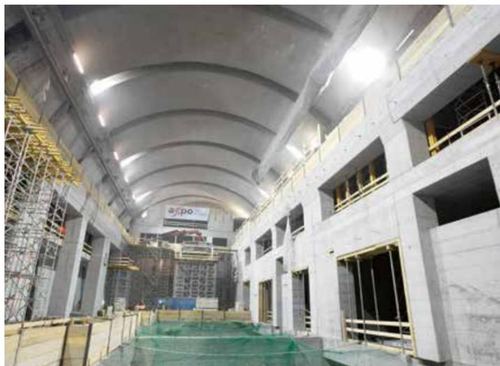
600 Meter im Berginnern auf 1700 Meter Höhe: Für die 150 Meter lange Maschinenhalle Linthal 2015 wurden 180.000 Kubikmeter Fels ausgebrochen. Hier werden jetzt die gewaltigen Pumpturbinen und Generatoren montiert. © Axpo
