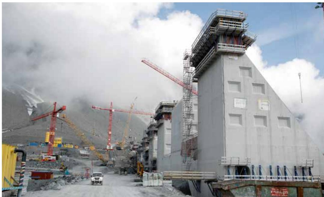
Die Staumauer für das Projekt Linthal 2015 besteht aus 68 Blöcken je 15 Meter Länge. Die fertige Sperre staut den Muttsee um 30 Meter auf. Der Beton wird an der Baustelle durch ein temporäres Betonwerk hergestellt. © Axpo
