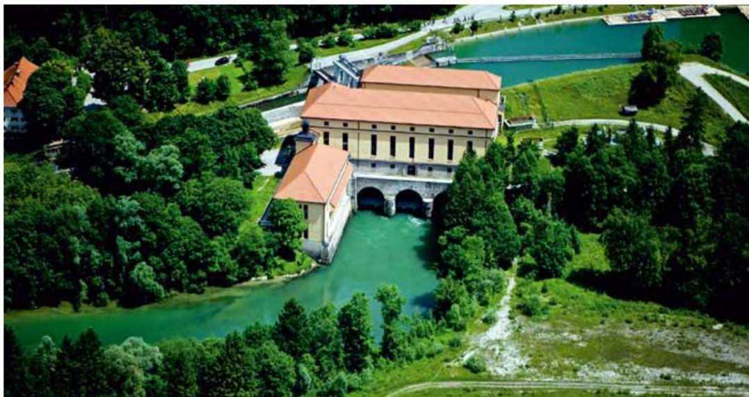
Das zwischen 1920 und 1924 entstandene und 11,2 MW starke (3 Francis-Turbinen) Laufwasserkraftwerk Mühltal im oberbayerischen Straßlach ist ein Blickfang und steht unter Denkmalschutz. Betreiber ist heute E.ON. © E.ON
