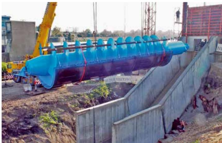
Die von Andritz in Ungarn gefertigte und gelieferte Wasserkraftschnecke ist mit 20 Tonnen ein Schwergewicht. © RMD AG
