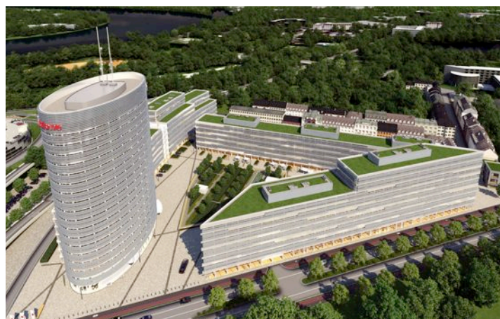
Vodafone investiert in seine neue Deutschland-Zentrale in Düsseldorf.
