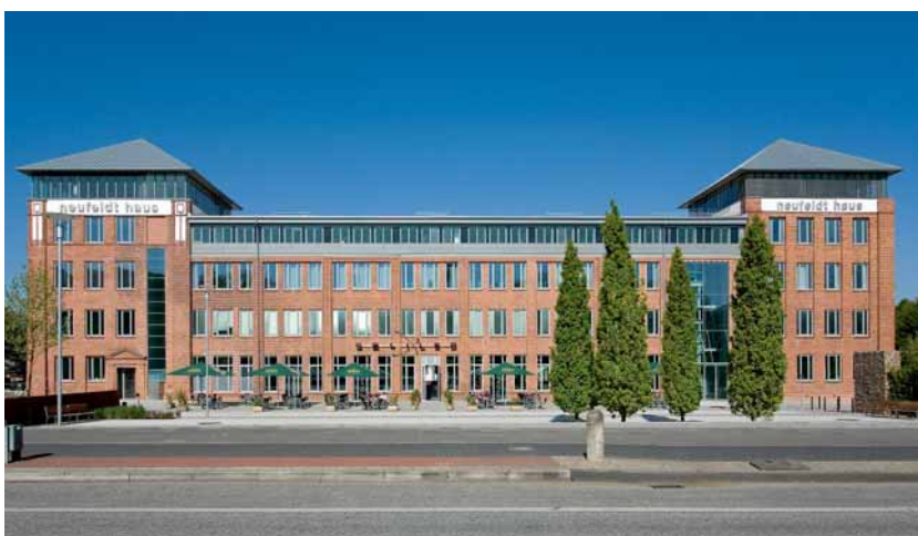
Das generalsanierte Neufeldt-Haus ist mit 10.000 qm Büro und Laborflächen Bestandteil des Wissenschaftsparks in Kiel.
