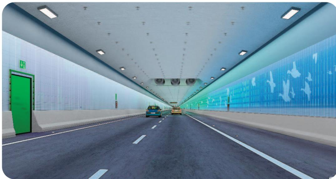
Computeranimation des Absenktunnels Fehmarnbelt-Querung (4-spurige Autobahn, zweigleisige Eisenbahn). © Femern
