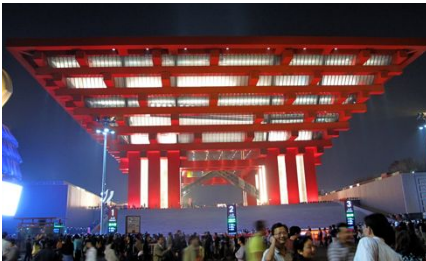
Der China-Pavillon ist das „grüne“ Wahrzeichen der EXPO. Das gesamte Ausstellungsgelände ist vollgepackt mit innovativer Technik von Siemens.
