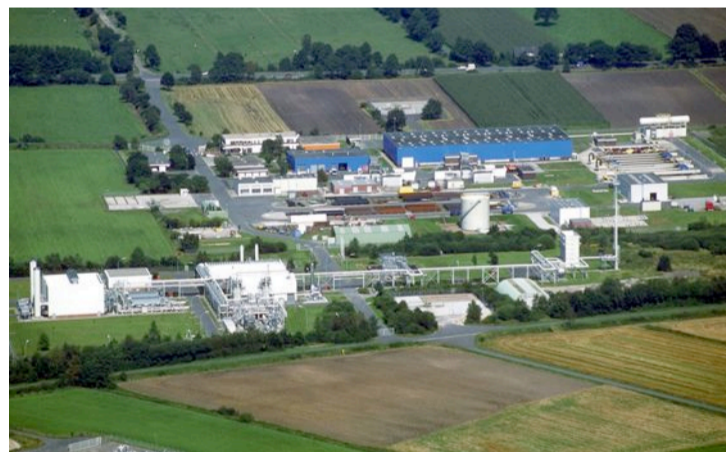
Gasspeicheranlage Etzel sichert wesentlich die deutsche Gasversorgung. © Statoil
