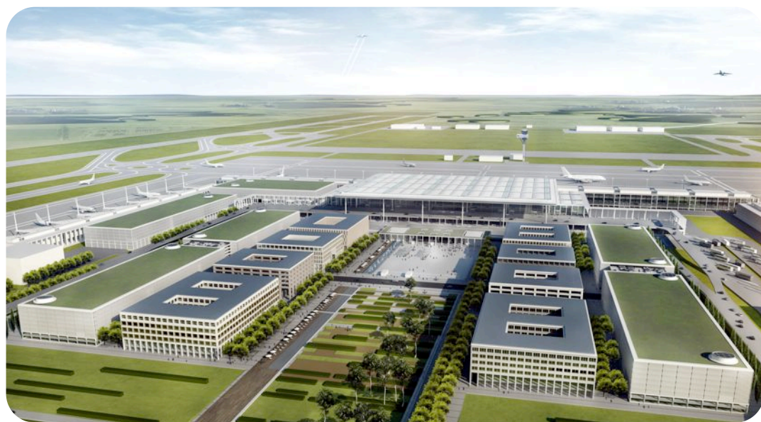
Pannen, Ärger und Kostenexplosionen: Berlins neuer Flughafen braucht weitere Kapitalspritzen. © Flughafen Berlin Brandenburg
