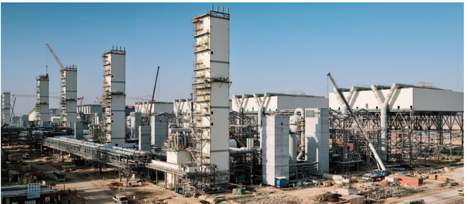
Die Linde AG errichtet in Katar den derzeit größten Luftzerlegungs-Komplex der Welt mit einer Kapazität von 860.000 Kubikmetern Sauerstoff pro Stunde.
