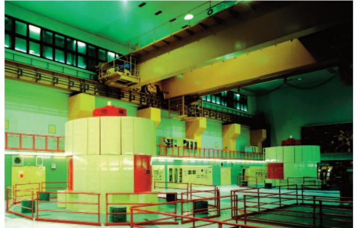
Maschinenhalle des Wasserkraftwerkes (2 x 325 MW) in Dlouhé Stráně.
