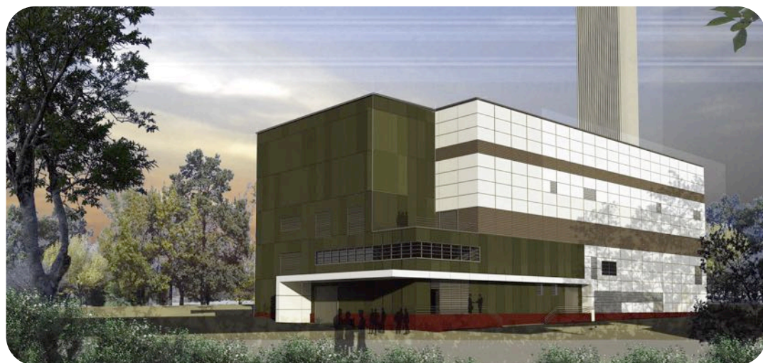
MTU sichert mit einem Erdgasblockheizwerk die Stromversorgung im Queen Elizabeth II Hospital in Perth. © Rolls-Royce
