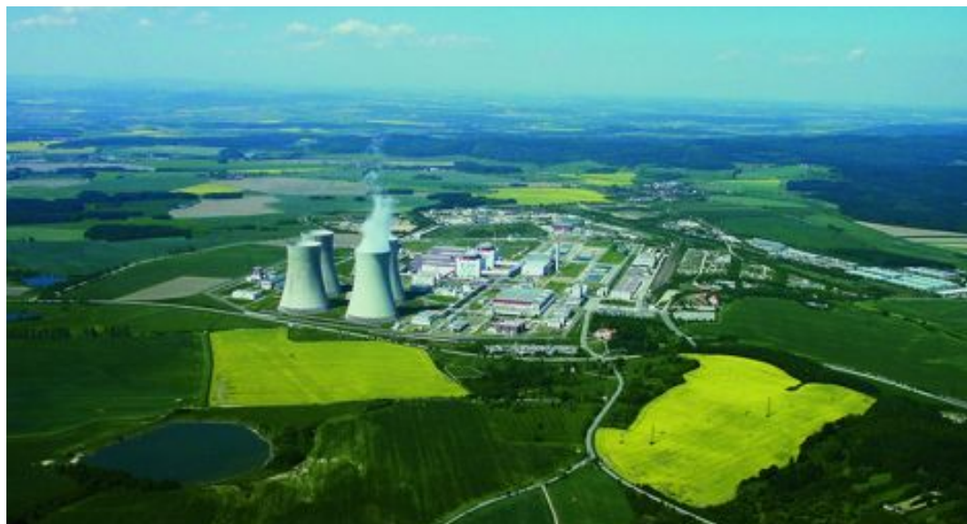
Das Kernkraftwerk Temelin (bei České Budejovice) gehört mit zwei 1.000 MW-Blöcken zu den modernsten Anlagen.
