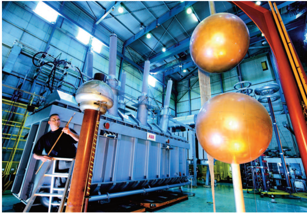
Transformatoren sorgen für die richtige Spannung der elektrischen Energie in die Übertragungsnetze.
