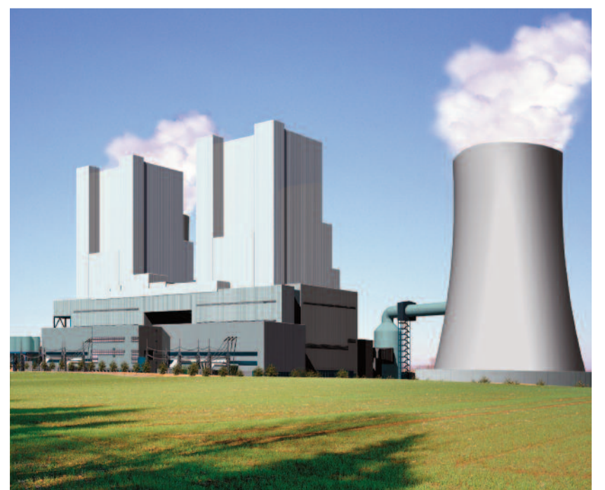
Modernste Braunkohlekraftwerke wie das derzeit entstehende RWE-Projekt in Neurath sichern deutsche Unabhängigkeit in der Stromerzeugung.
