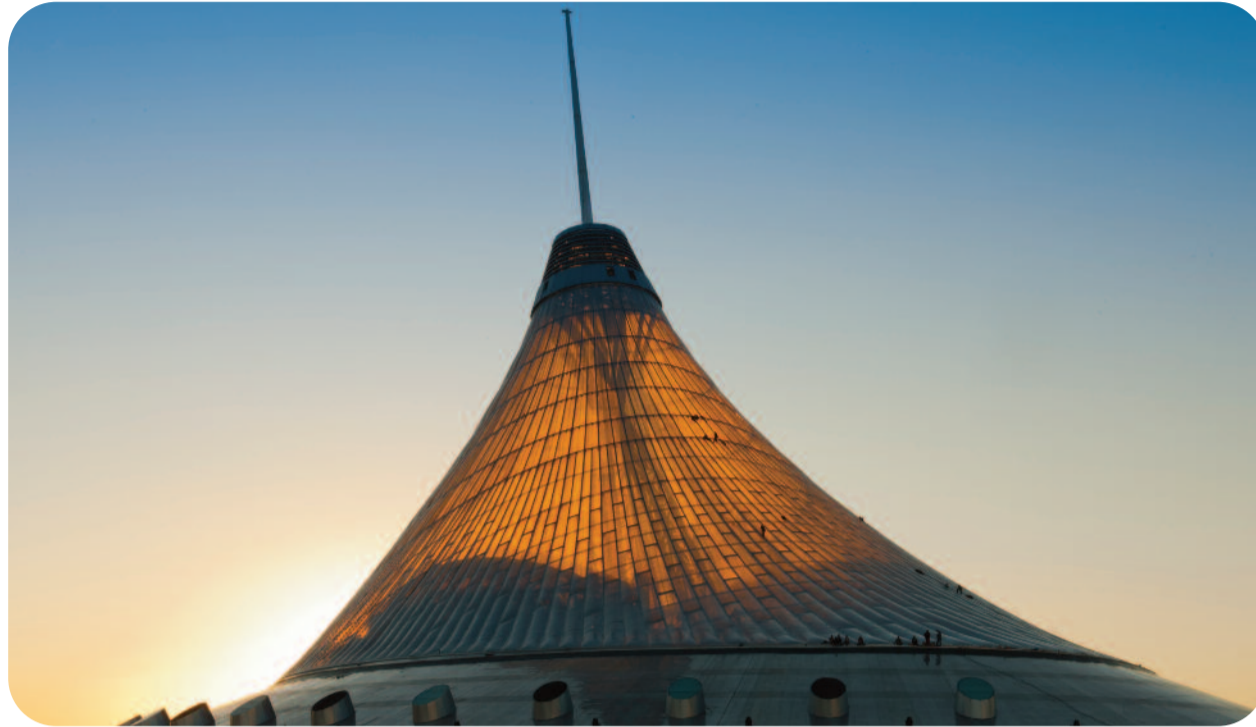
Muss extremen Wetterbedingungen standhalten: Das mit der Folie der Bremer Firma Vector Foiltec GmbH ausgestattete Dach des Khan Shatyr Entertainment Center in Astana, Kasachstan.
